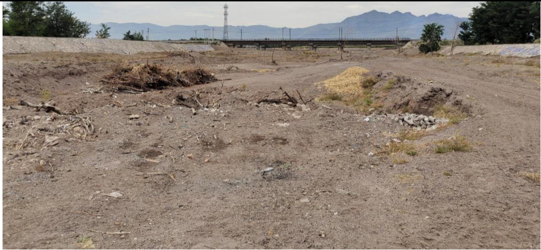
图 31 包兰铁路桥段至小王泉沟过水路面段沟道现状
