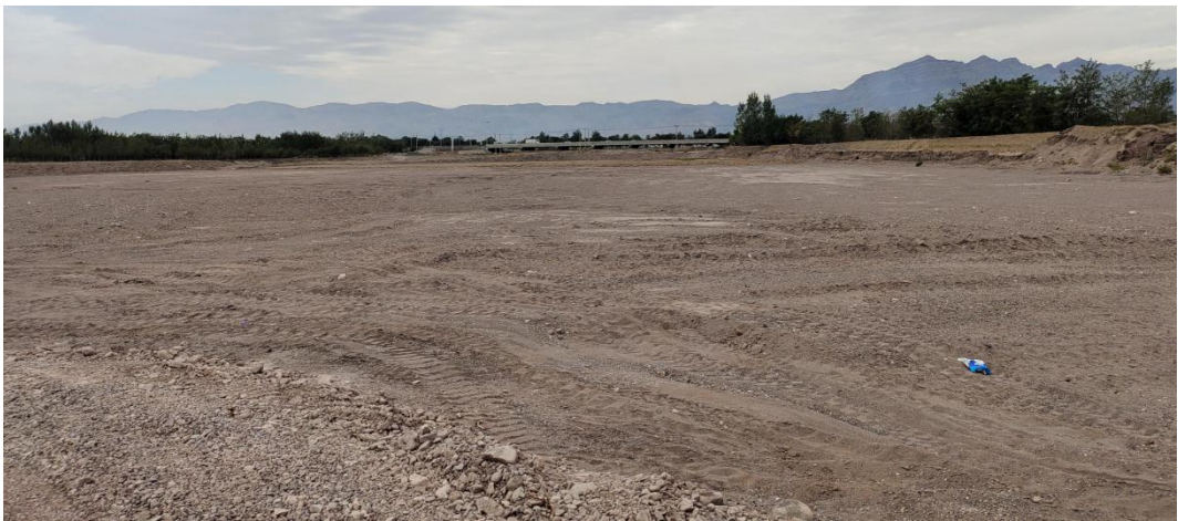
图 30 小王泉沟公路桥至包兰铁路桥段沟道现状
