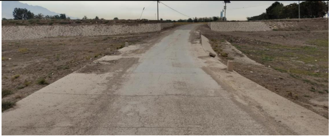
图 32 大王泉沟过水路面现状
